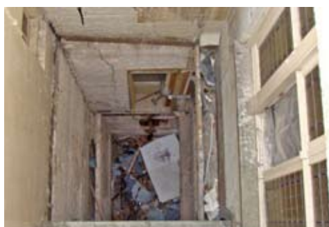
Ruimte waar de lift zal worden gerealiseerd
